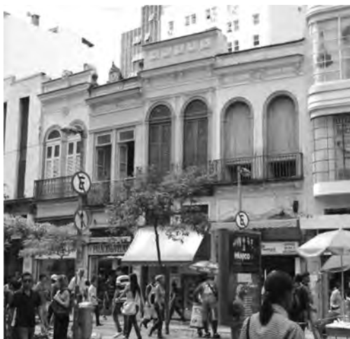
Figuras 2 e 3 – Rua Uruguaiana entre as ruas Sete de Setembro e Ouvidor, lado par. Observam-se edificações em lotes muito estreitos, de pouco mais de três metros de testada. Fotos: Paula De Paoli, 1/7/2011 e 13/4/2011.
